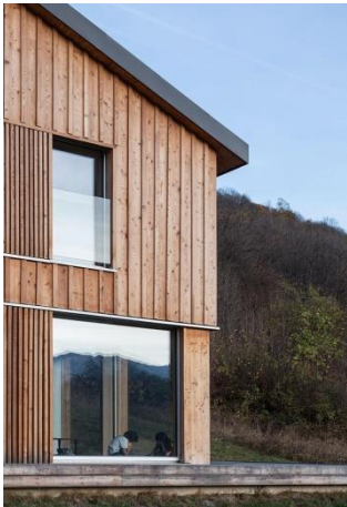
Maison à BEAUNE (73) - DAMIEN VIGNON ARCHITECTE (69)
